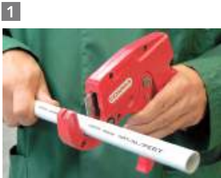
1 CUT THE PIPE SQUARE / TAGLIARE IL TUBO PERPENDICOLARMENTE / ABLÄNGEN DES ROHRES / COUPER LE TUBE DROIT
